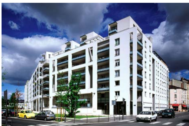
Les Aravis – Lyon 7 62 logements livrés en 2002, îlot composé également de locations sociales et d'accession.
